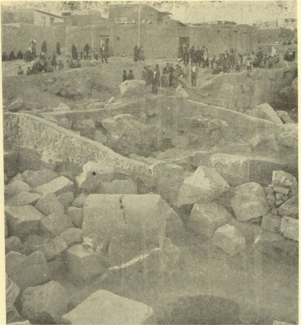
شکل شماره ۴ - چند ترانشه حفاری که تا پای خانه‌های روستائی مردم کنگاور ادامه یافته ، نشان دهنده ادامه دیوار شرقی معبد ، در زیر خانه هاست
