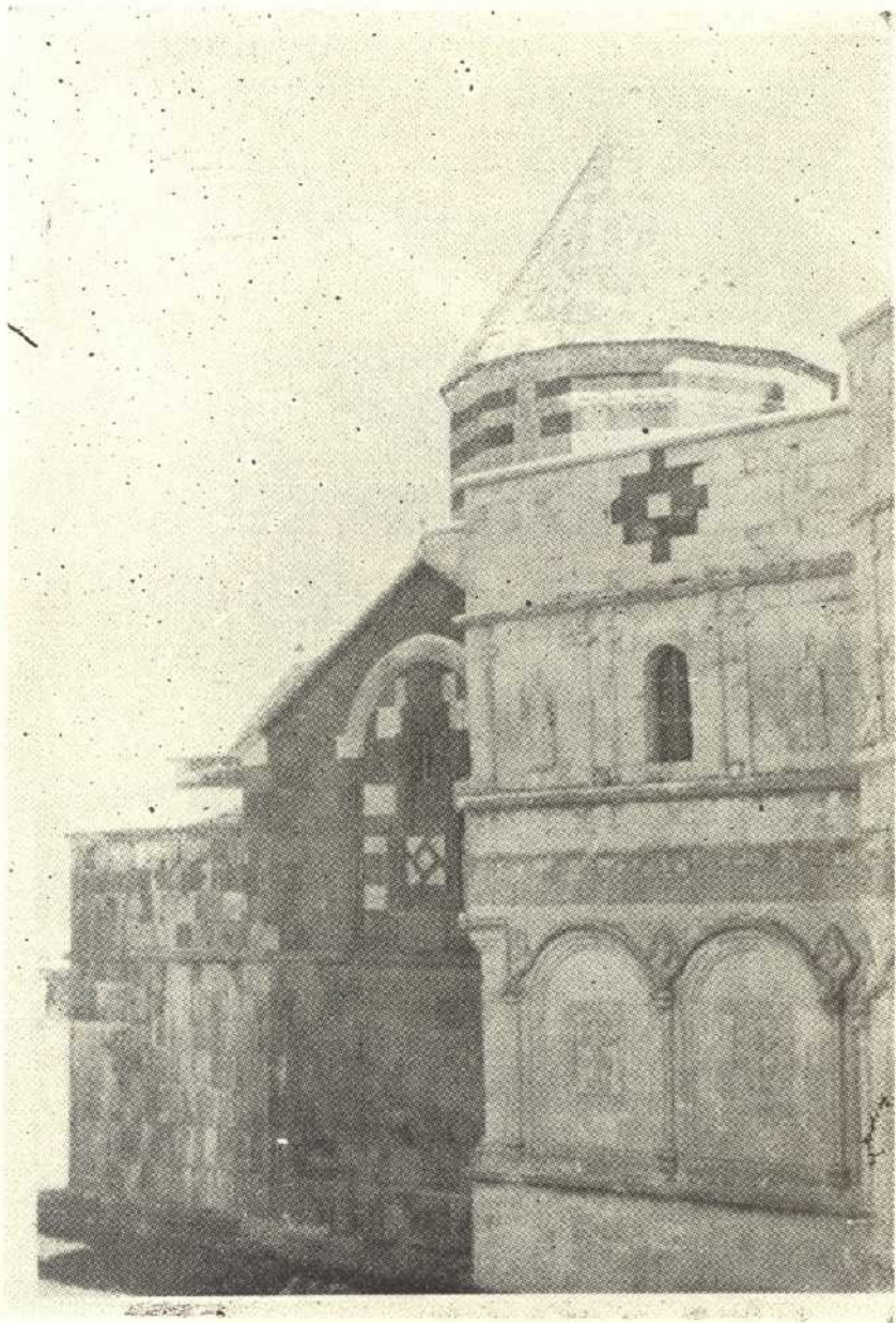
نمای گنبد كوچك و ديوار كليسا (شكل شماره ۲)
