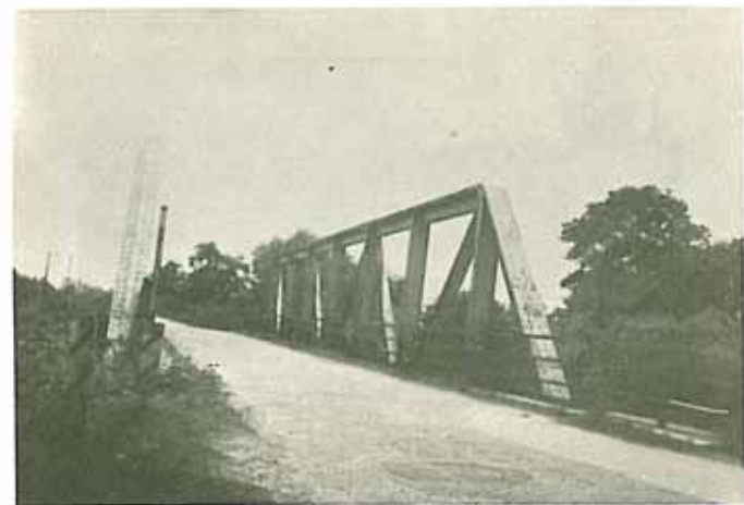
پل فلزی بر روی رودخانه نمک‌آبرود
