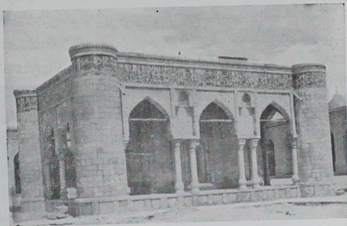
خدای خانه مسجد جامع عتیق شیراز
