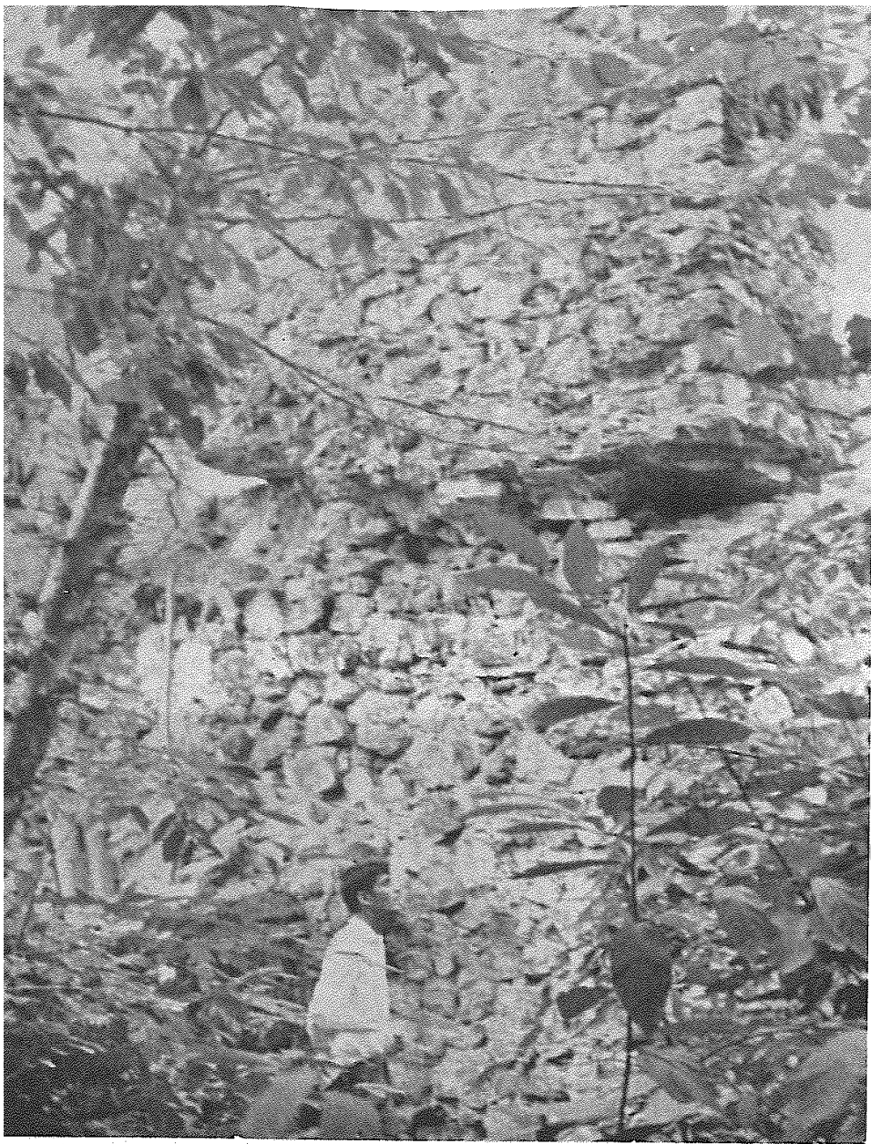
(عکس شماره ۲۶۰) قسمتی از دیوار قلعه تولات در اراضی تولات
