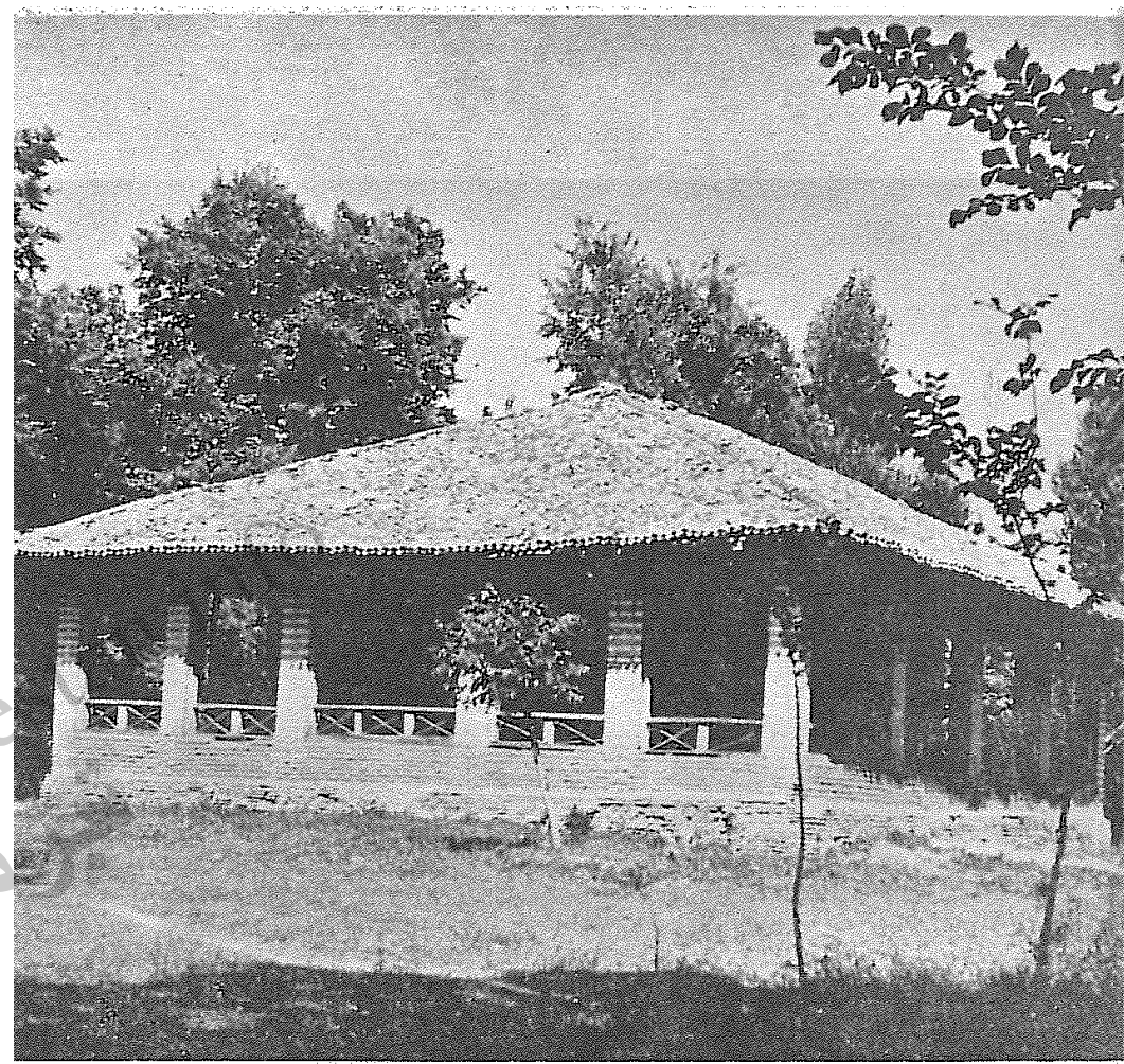
(عکس شماره ۱۴۴) نمای خارجی بقعه آقاسیدجانی در دهکده سیاه کوجه آستانه
