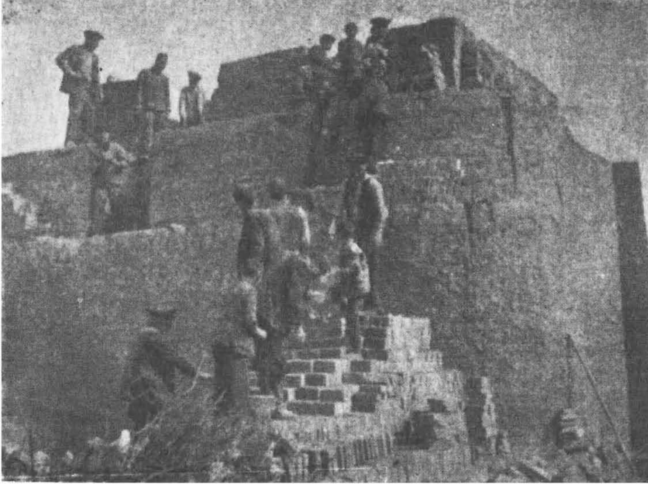
تصویر ۲۲، کارگران مشغول «سرچین» کردن کوره هستند. (ص ۷۱)
