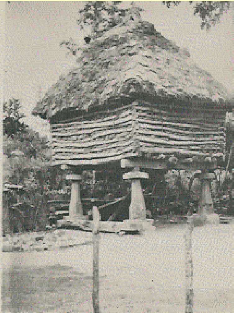
گندوج - وسیله‌ای که شلتوک را در آن انبار میکنند و درینای آن مسئله گریز از رطوبت و حیوانات خا کزی جوئنده چون موش مؤثر بوده است .
